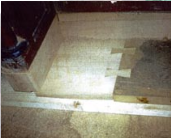
Angearbeitetes Brett mit Schwalbenschwanz- verbindung.
