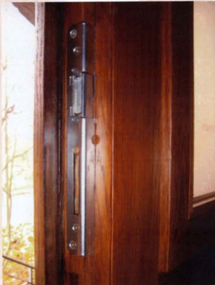
Das neu eingearbeitete Sicherheits-schließblech
