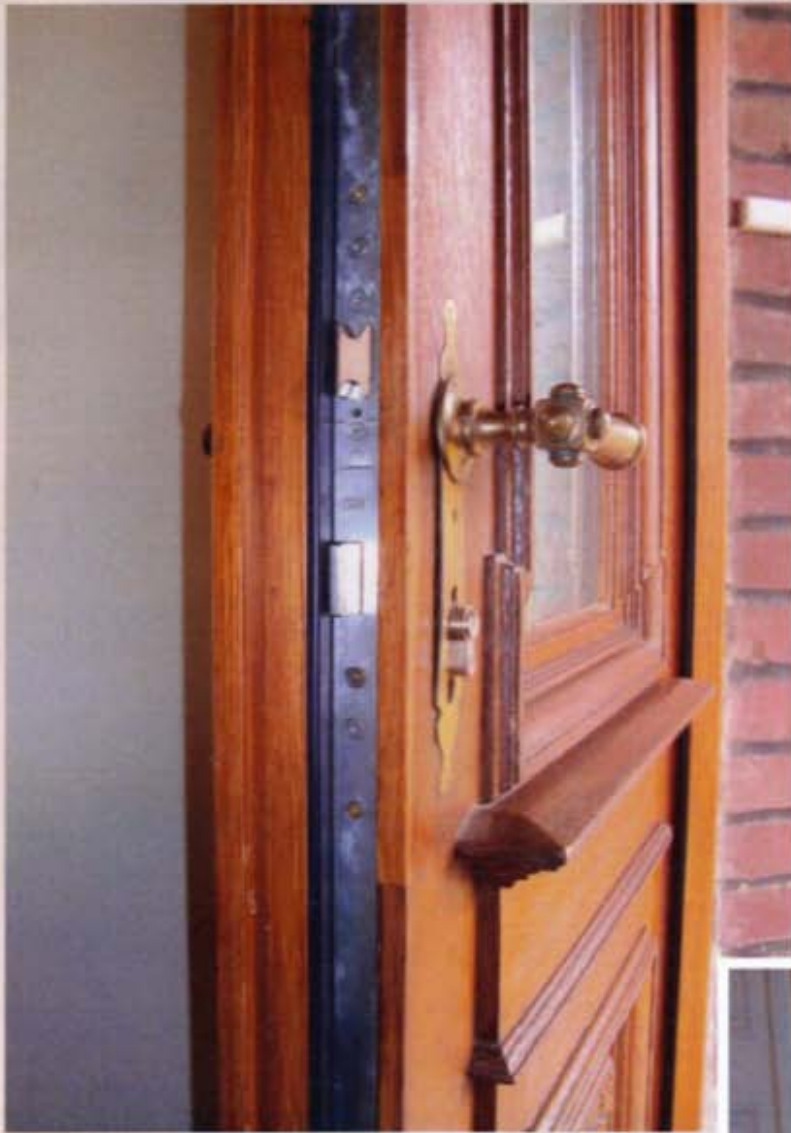
Modernes Haustürschloß mit Dreifachverriegelung und Profilzylinder
