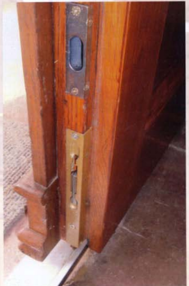
Das neu eingearbeitete Sicherheits-schließblech
