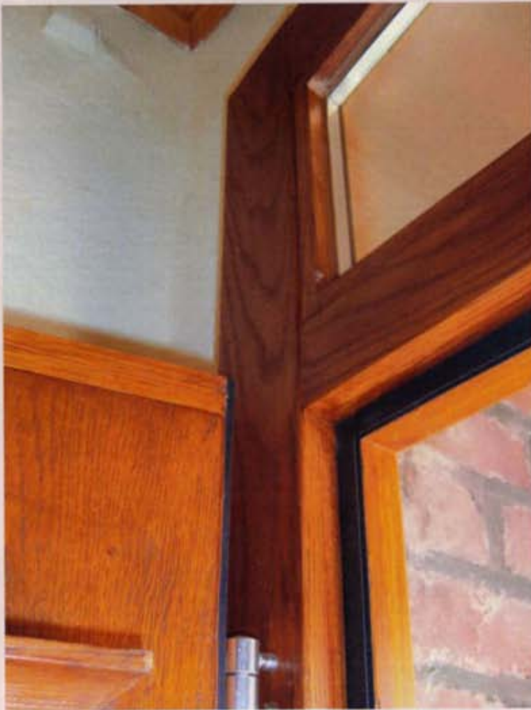
Der neu erstellte Blendrahmen mit Oberlicht und Isolierverglasung.
